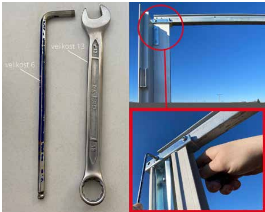
Obrázek 23 Odstranění předního vodícího profilu
