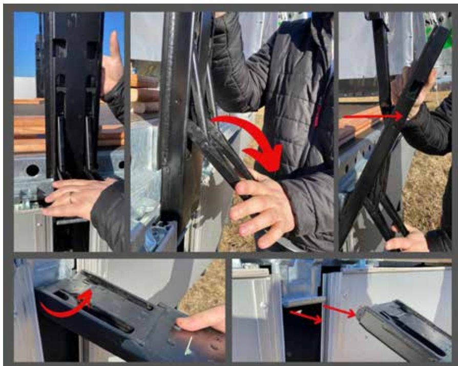
Obrázek 7 Odejmutí sloupku KINEGRIP
