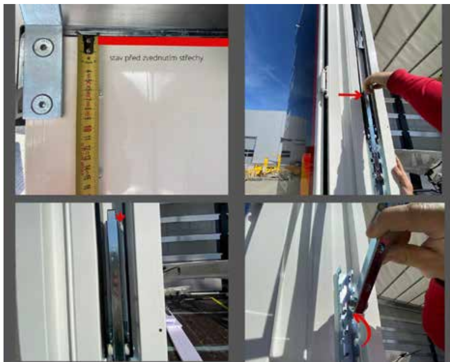
Obrázek 16 Zvedání střechy na zadních rohových a předních rohových sloupcích - dvoustavová střešní konstrukce
