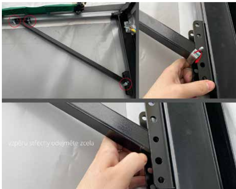
Obrázek 21 Odejmutí vzpěry střešní konstrukce
