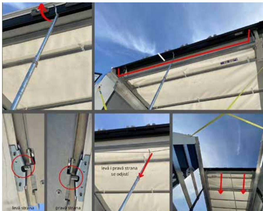
Obrázek 15 Shrnování střešní plachtové konstrukce
